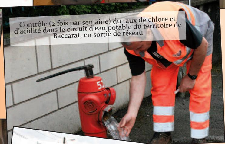
Contrôle (2 fois par semaine) du taux de chlore et d'acidité dans le circuit d'eau potable du territoire de Baccarat, en sortie de réseau
