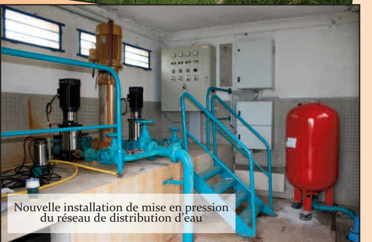
Nouvelle installation de mise en pression du réseau de distribution d'eau
