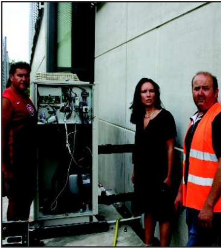
Après des travaux préalables nécessaires (réalisation d'une dalle notamment) un groupe d'eau glacée a été installé au pôle sportif. La mission de cette installation est d'assurer **une baisse de la température intérieure de -6°C** par rapport à la température extérieure, ainsi que de favoriser le renouvellement d'air.
