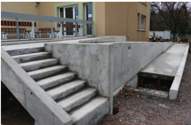
Travaux extérieurs à la résidence Pasteur / rampe PMR*
