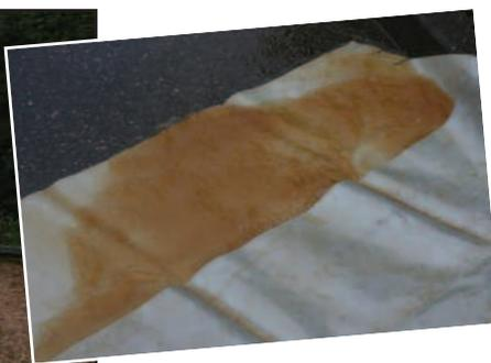
L'opération de nettoyage des canalisations d'eau niveau haut de la rive gauche s'est déroulée plus rapidement que prévue, grâce à l'investissement et l'efficacité du personnel du service des eaux, soucieux de limiter au maximum les désagréments liés aux coupures d'eau. La couleur du rejet des eaux montre combien ce nettoyage par procédé air-eau était nécessaire à l'entretien de ces conduites.
